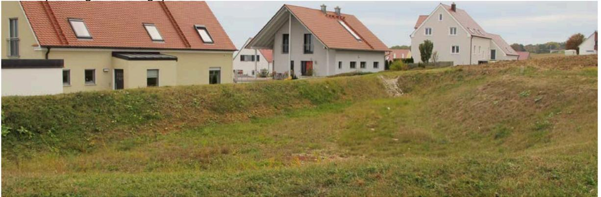
Abbildung 2: Regenwasserrückhaltebecken nördlich des Baugebietes „An der Nagelgasse“
