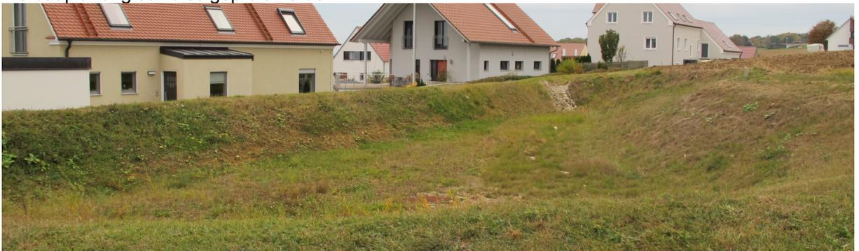
**Abbildung 8: Regenwasserrückhaltebecken-Beispiel nördlich des Baugebietes „An der Nagelgasse“**
